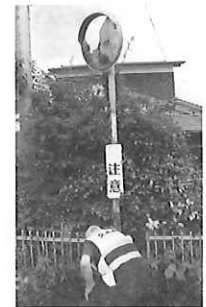
ポールの根元の点検
