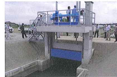
【完成した仲田代水門東樋門】
