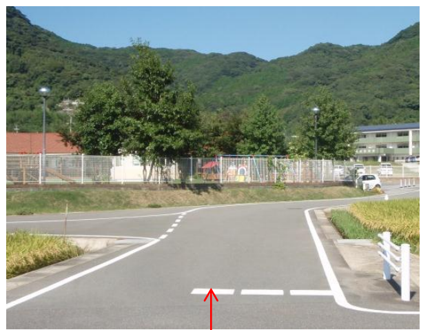
【指導停止線(破線)】標識なし
