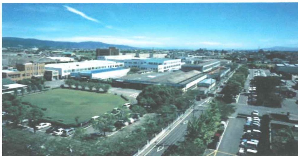
株式会社 戸上電機 製作所の 社屋と本 社工場群 (HPより 転載)
