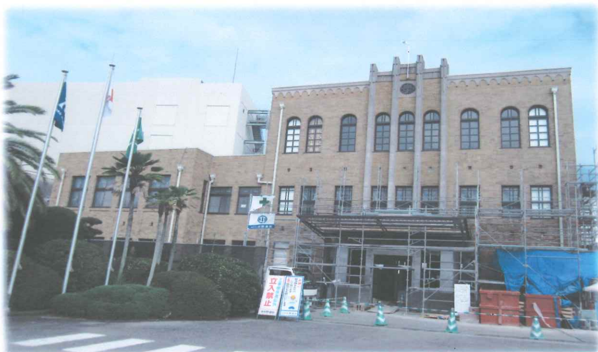
創業年(1925年)建設の社屋は耐震工事中でした。今年中に工事は竣工するとのこと。
