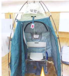
《下水用トイレ》 下水柱のある所に設置
