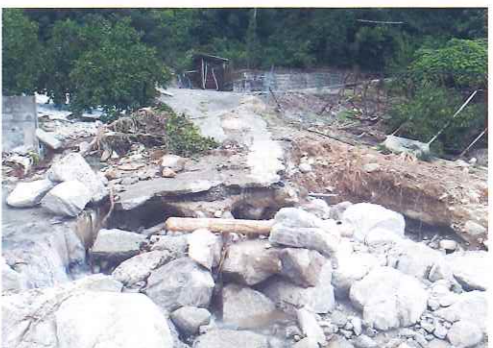
土石流で崩落した道路と河川
