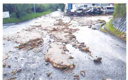
道路上に堆積した土砂
