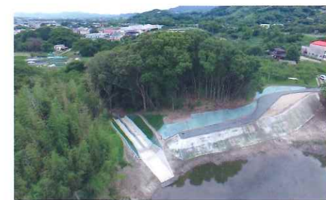
完成後の小川新堤
