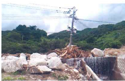
巨石が衝突し傾いた電柱
