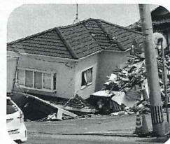
倒壊した家屋
