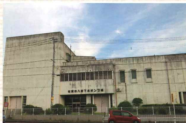
八田ポンプ場
