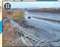
B 城原川に残る橋脚基礎跡
