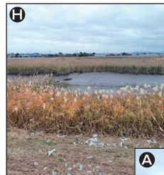
H 田手川に残る未成線の土に埋もれた橋脚
