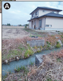
A 両岸に残る橋台
