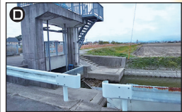
D 犬尾橋水門
