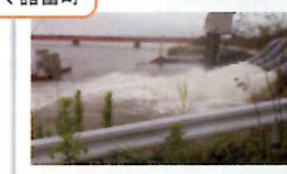
R3.8.14 ドロン横水門
