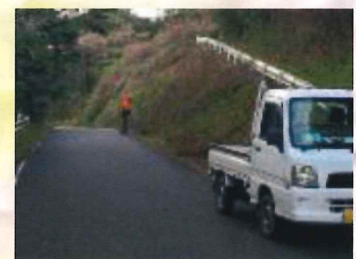
林道 法面草刈り
