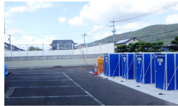
鹿島市の小学校で設置した際のマンホールトイレ
